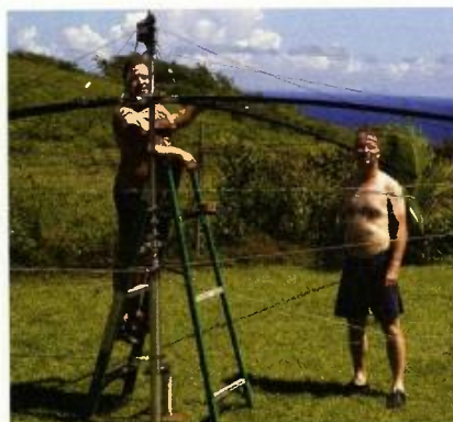
Obr. 4. Stavba spiderbeamu
