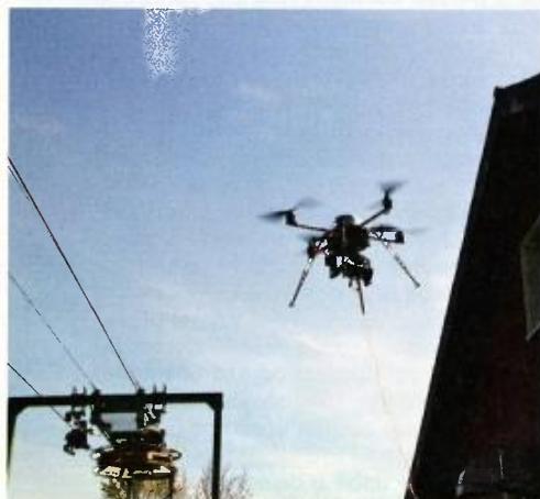
Obr. 4. Pomocná šňůra přes lyžařský vlek
