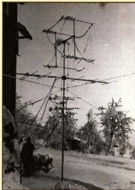
Obr. 30. Antenní systém pro pásma 2 m až 13 cm jako „ozdoba“ hotelu Panorama na Benecku. Kabely vedou do kotelny, kde bylo pracoviště
