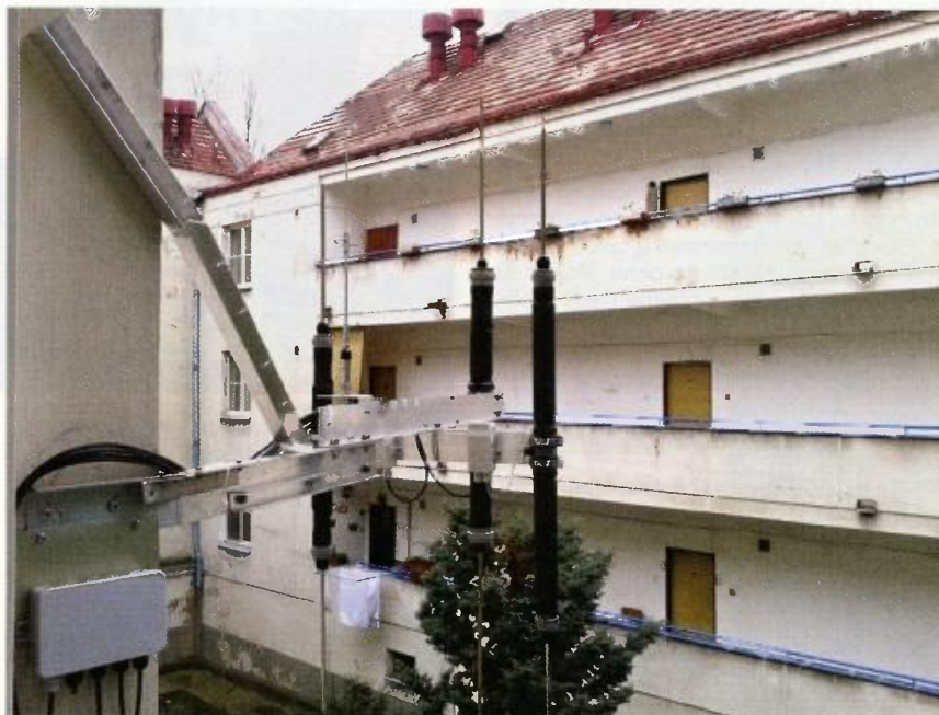
Obr. 9. Pohled na montáž antén
